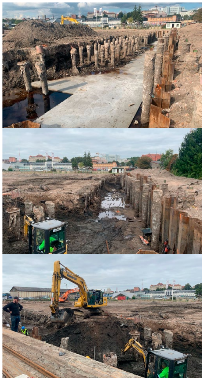
Fot. 1–3. Dokumentacja zdjęciowa robót ziemnych
